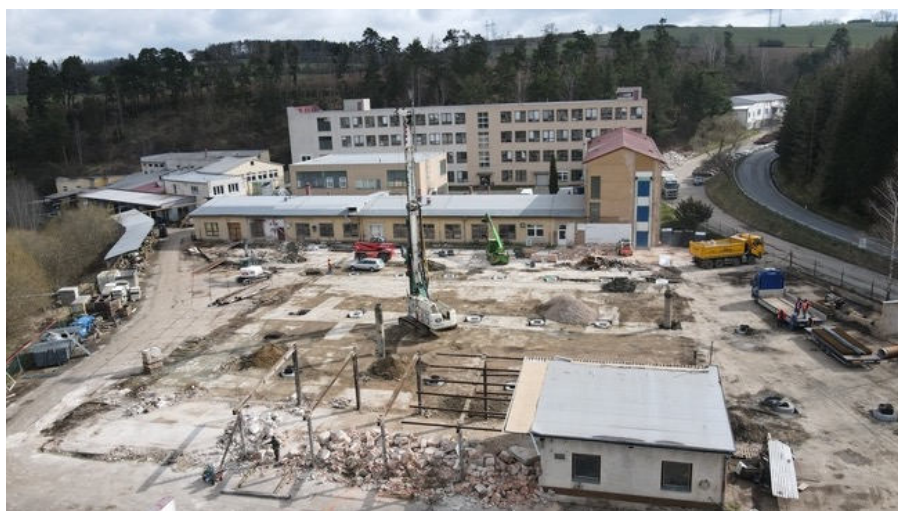
Fotografie staveniště v Brtnici během demoličních prací a základních stavebních úprav.
